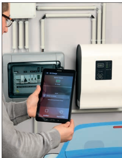
La borne de recharge communique en Wifi ou Bluetooth. Le réseau wifi créé en local est propre à la maquette. Il est isolé du réseau Wifi de votre établissement.
